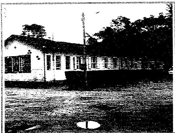
F03 • Vista lateral do prédio "Hospital"
