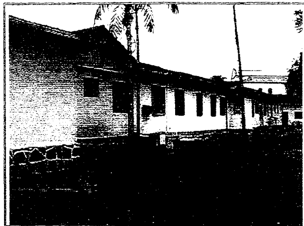
F04 • Vista dos fundos do prédio "Hospital"
