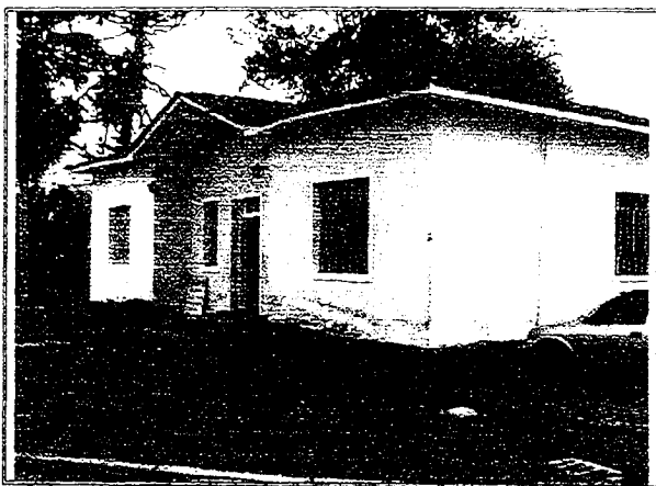
F05 • Vista da fachada do prédio "Administração"
